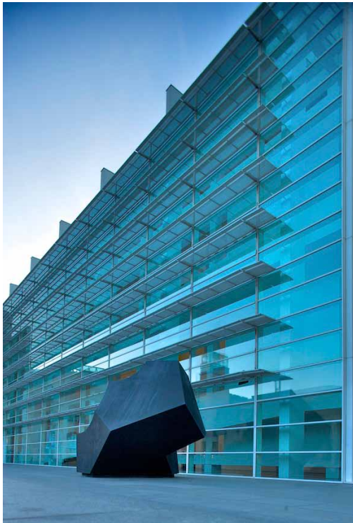
Höchste Anlagensicherheit und unterbrechungsfreie Stromversorgung in Zweckbauten.
