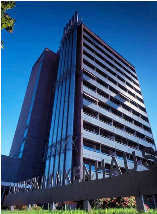
Durch die Transparenz der Energieflüsse lassen sich Einsparpotentiale leicht identifizieren.
