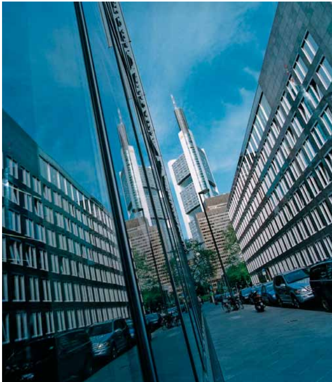
Sicherer Betrieb und platzsparender Aufbau sind für die Energieversorgung in der Infrastruktur wichtig.
