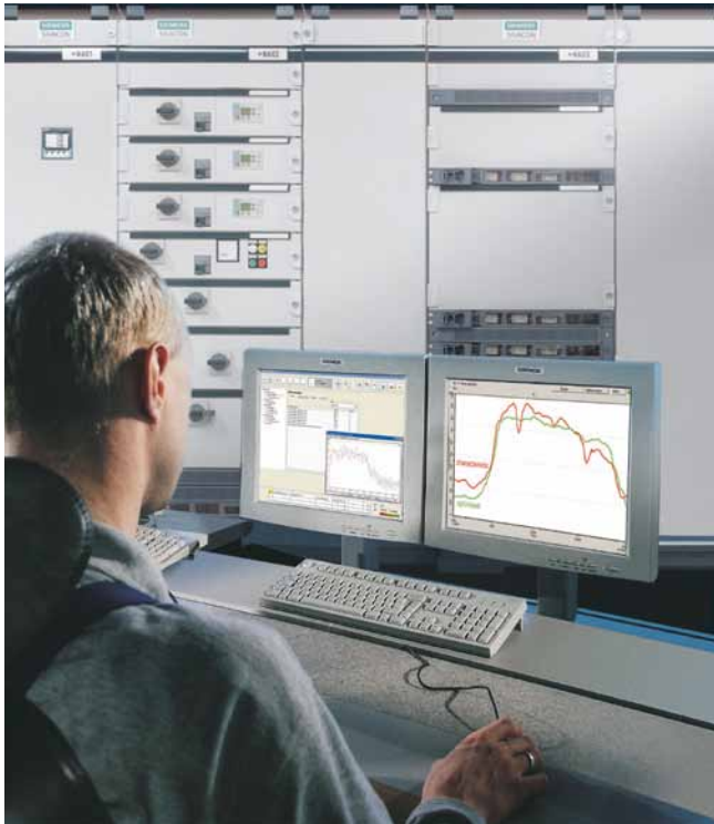
Durch die Transparenz der Energieflüsse lassen sich Einsparpotentiale leicht identifizieren.
